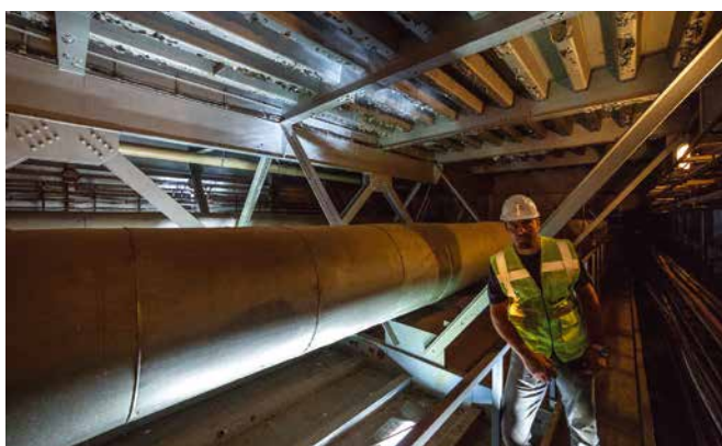
24. kép: Hídvizsgálaton Pozsonyban
