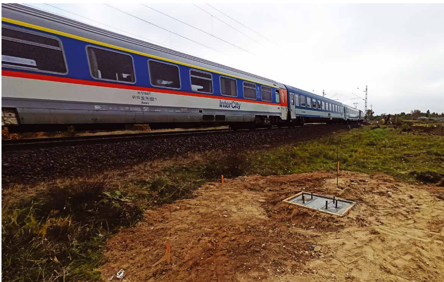
8. kép: Előkészítő munkák a terelővágány helyén [fotó: Somogyvári Péter, A-Híd Zrt.]
