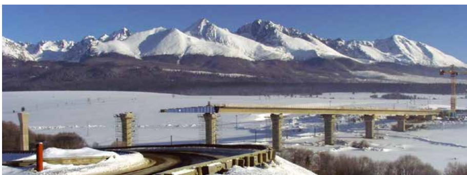
2. kép: A csorbai betolt híd a Magas Tára lábánál
