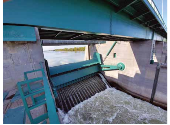
Dunakiliti duzzasztómű felújított VI-os szegmensnyílás
