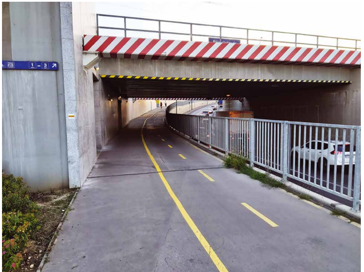
10. kép: A projekt keretein belül építendő aluljáróhoz nagyon hasonló műtárgy, a szintén cégünk által kivitelezett pilisvörösvári aluljáró [fotó: Speciálterv Kft.]
